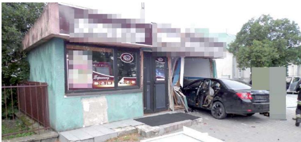
Tak wygląda budynek po sklepie z pieczywem po uderzeniu rozpędzonego samochodu
