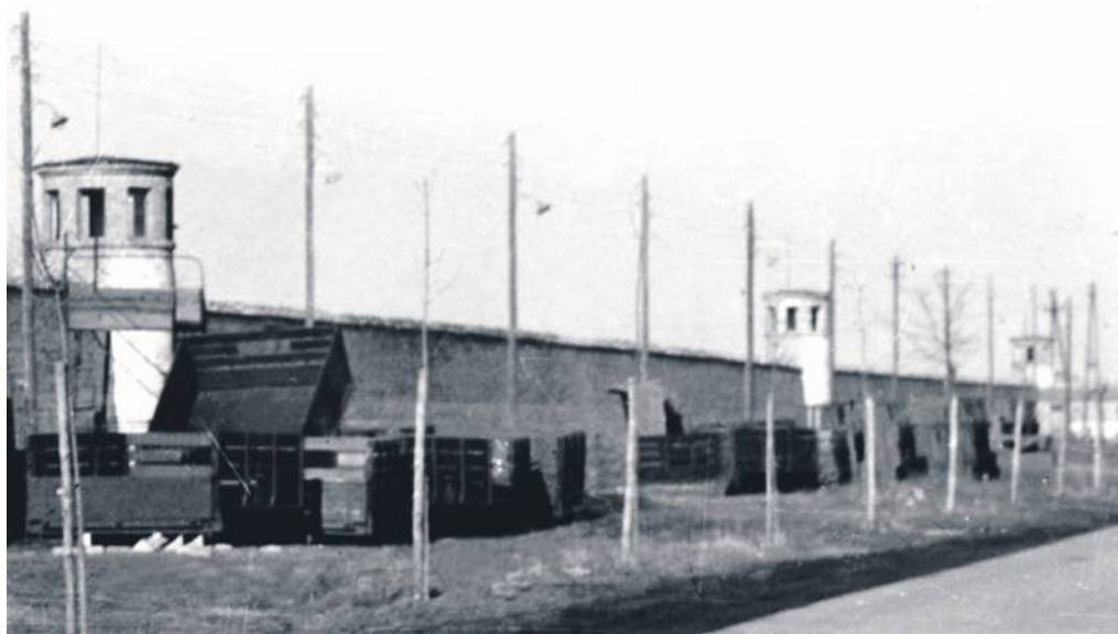
Pod koniec 1952 roku, gdy obóz formalnie już działał, dobudowano wieżyczki do więziennych murów
