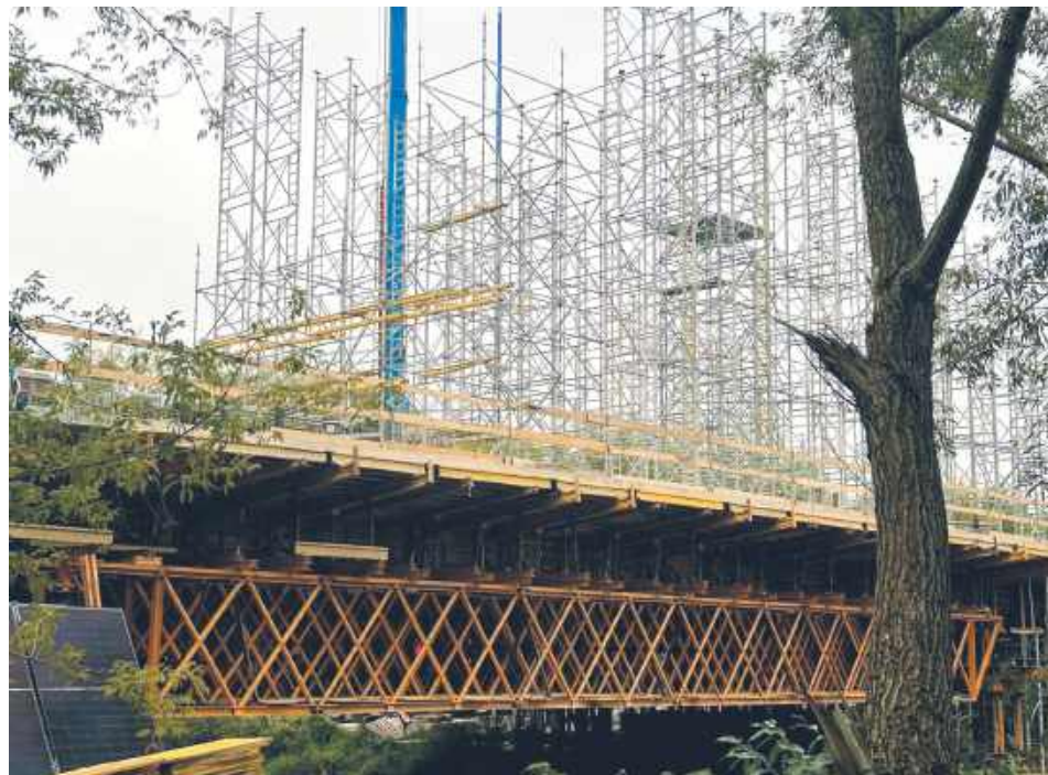
Budowa przeprawy mostowej
