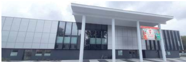
Już tylko kilka tygodni dzieli mieszkańców Puław od wielkiego otwarcia zmodernizowanego Puławskiego Ośrodka Kultury „Dom Chemika”. Remont trwał od 2018 r.
