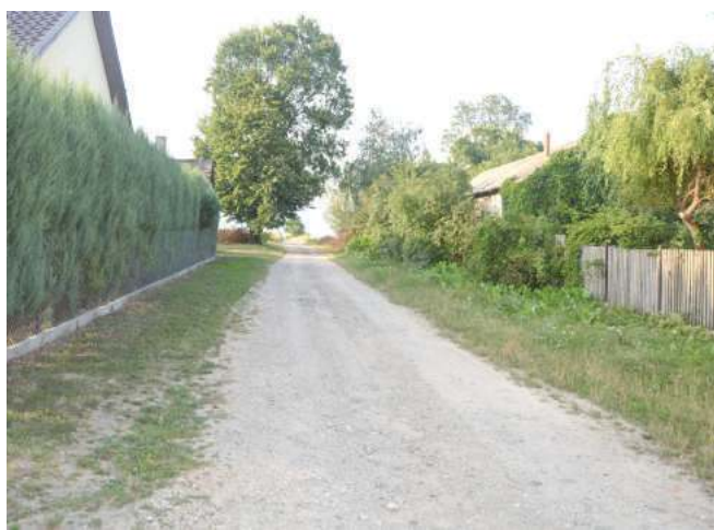
W tym miejscu mieszkańcy Woli Osińskiej zyskają nową drogę asfaltową, która powstanie w przyszłym roku
