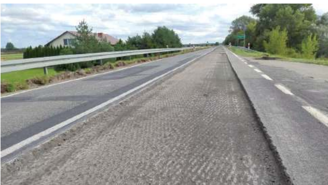
Drogowcy zdejmują starą, pofałdowaną nawierzchnię i kładą nowy dywanik asfaltowy
