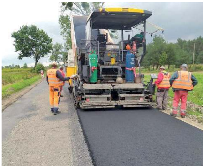
Firma ze Zwolenia już remontuje drogę powiatową. Kierowcy muszą liczyć się z utrudnieniami
