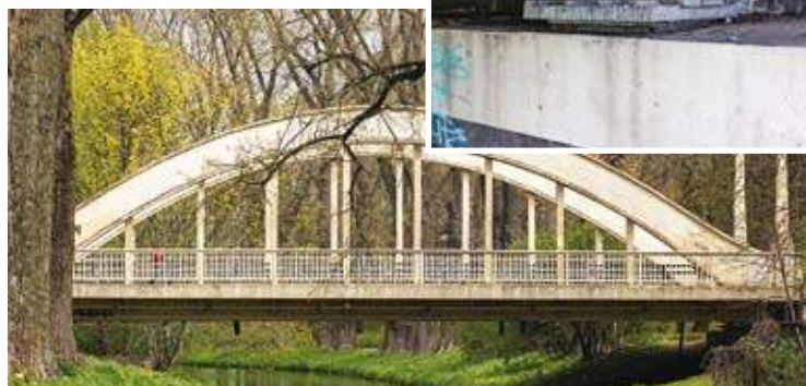
Bezpośrednią przyczyną awarii było działanie człowieka. Kradzież łożyska
