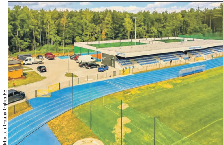
Miejski Stadion Leśny przy ul. Dobrzykowskiej w Gąbinie przeszedł modernizację
