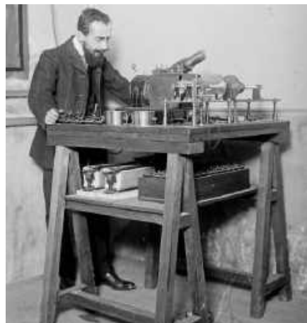
Rysunek 12. „Bélinographe” z 1907 roku, wykorzystujący fotokomórkę do skanowania i przesyłania zdjęć. Źródło: https://www.wiki/7DAK
