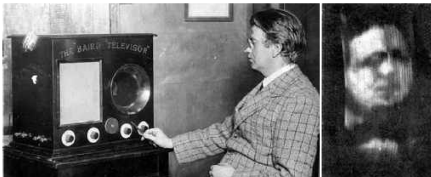
Rysunek 18. Po lewej: John Logie Baird ze swoim „Televisorem” – pierwszym dostępnym handlowo telewizorem z 1926 roku. Po prawej: wyświetlana w „Televisorze” twarz partnera biznesowego Bairda. Źródło: https://rts.org.uk/article/remembering-logie-baird-ninety-years
