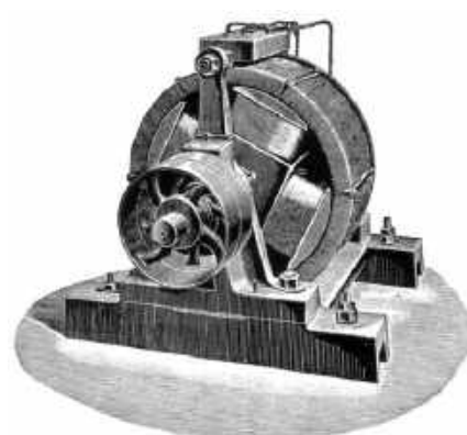
Rysunek 6. Trójfazowy generator Haselwandera z nieruchomą armaturą pierścieniową i czterobiegunowym wirnikiem, zaprezentowany w 1891 roku na Międzynarodowej Wystawie Elektrycznej we Frankfurcie. Źródło: https://w.wiki/7DAZ
