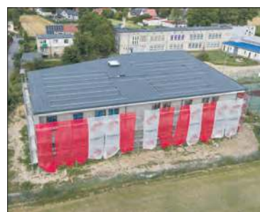
Aktualny stan budowy przedszkola w Lubrzy
