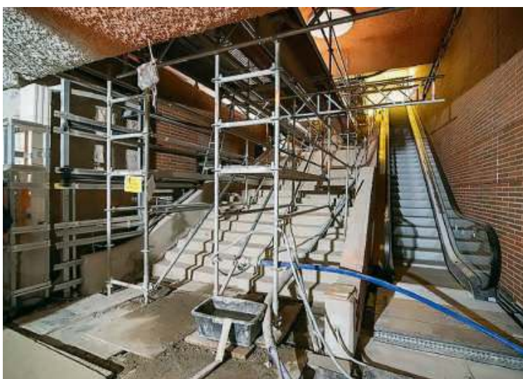
Budowa stacji C04 Bemowo | fot. Um.warszawa.pl/d
