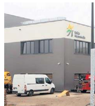
Dobiegają końca prace związane z budową bazy.
