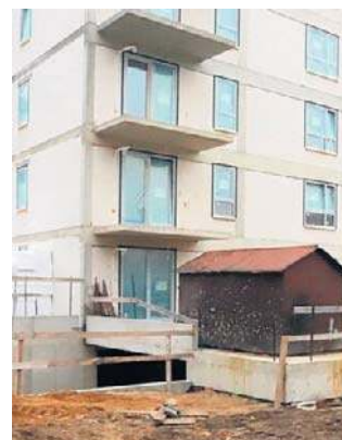
Apartamentowce stoją trwa „wykończeniówka”.
