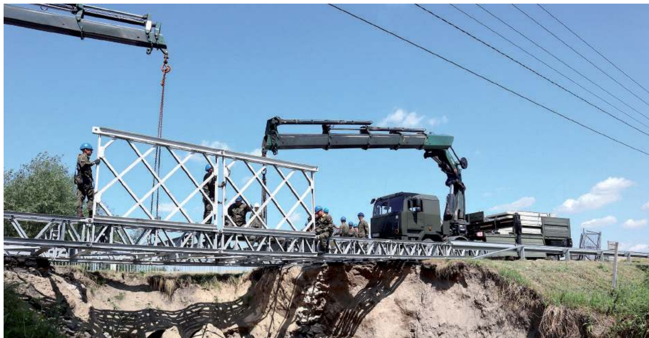
Żołnierze z batalionu drogowo-mostowego z jednostki wojskowej z Dębina rozpoczęli 25 lipca montaż składanego mostu tymczasowego
