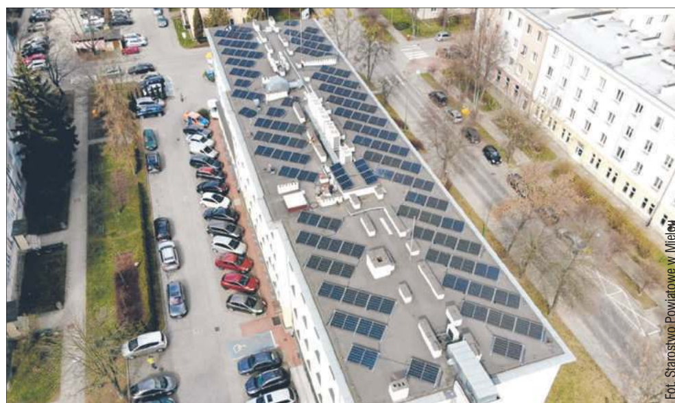
Panele pozwolą pokryć zapotrzebowanie energii elektrycznej starostwa na poziomie około 30 proc. zapotrzebowania rocznego.
