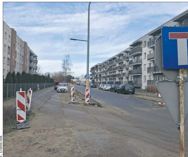
Prace na ul. Maneżowej
