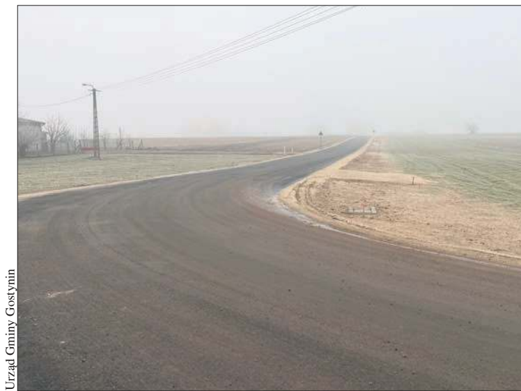
Zakończyła się rozbudowa drogi gminnej w m. Budy Kozickie
