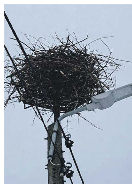
Gniazdo bocianów na infrastrukturze drogowej
