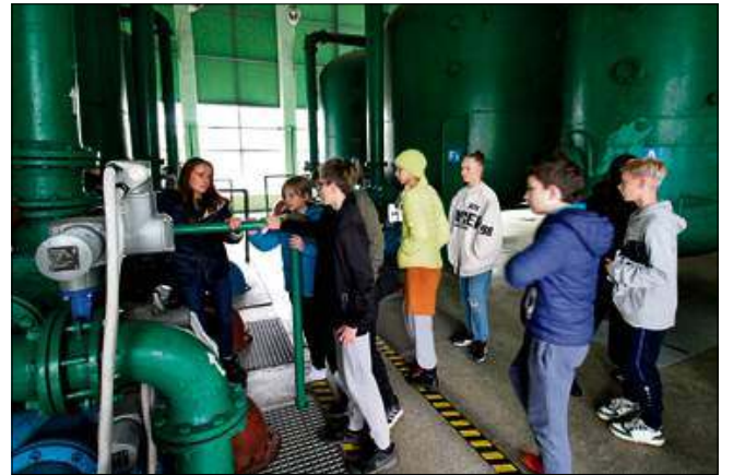
Zwiedzanie stacji uzdatniania wody.
