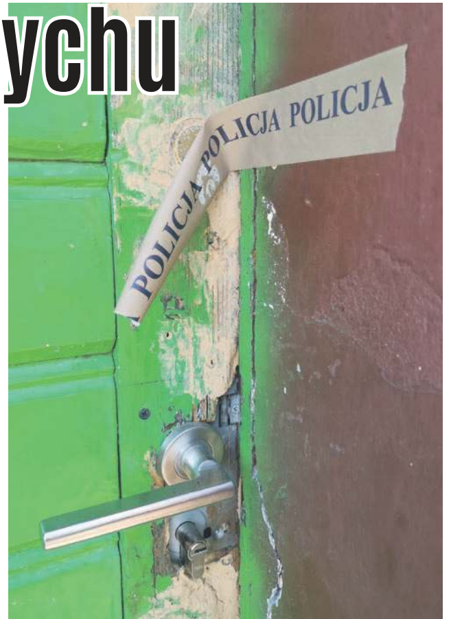
Okna i drzwi oklejono taśmą policyjną, ale przy drzwiach wejściowych już ktoś ją odkleił. Jeśli chciał wejść, to wszedł
