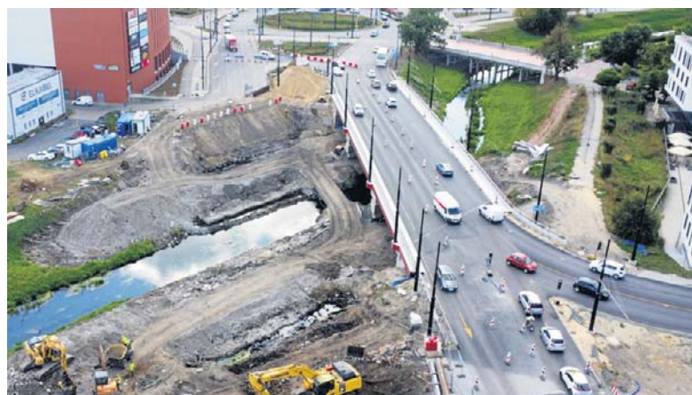
Widok na nowy most na Bystrzycy. Po jego lewej stronie znajdował się stary most. Pozostały po nim tylko ślady na brzegu rzeki
