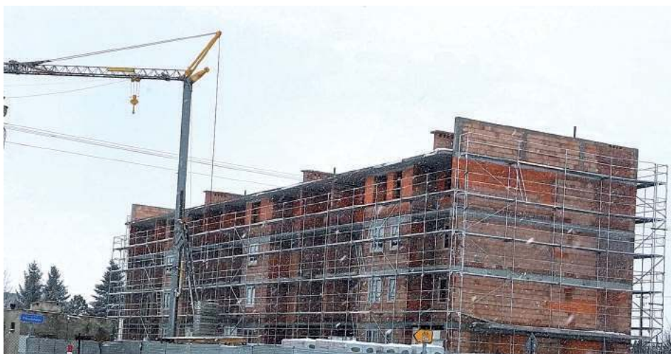
W tym roku sfinalizowana będzie budowa bloku komunalnego
