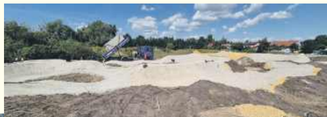
Widoczny postęp prac przy budowie pierwszego pumtracka w gminie
