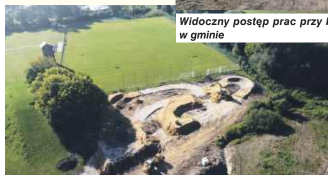
Budowa pumtracka w Krzyżanowicach
