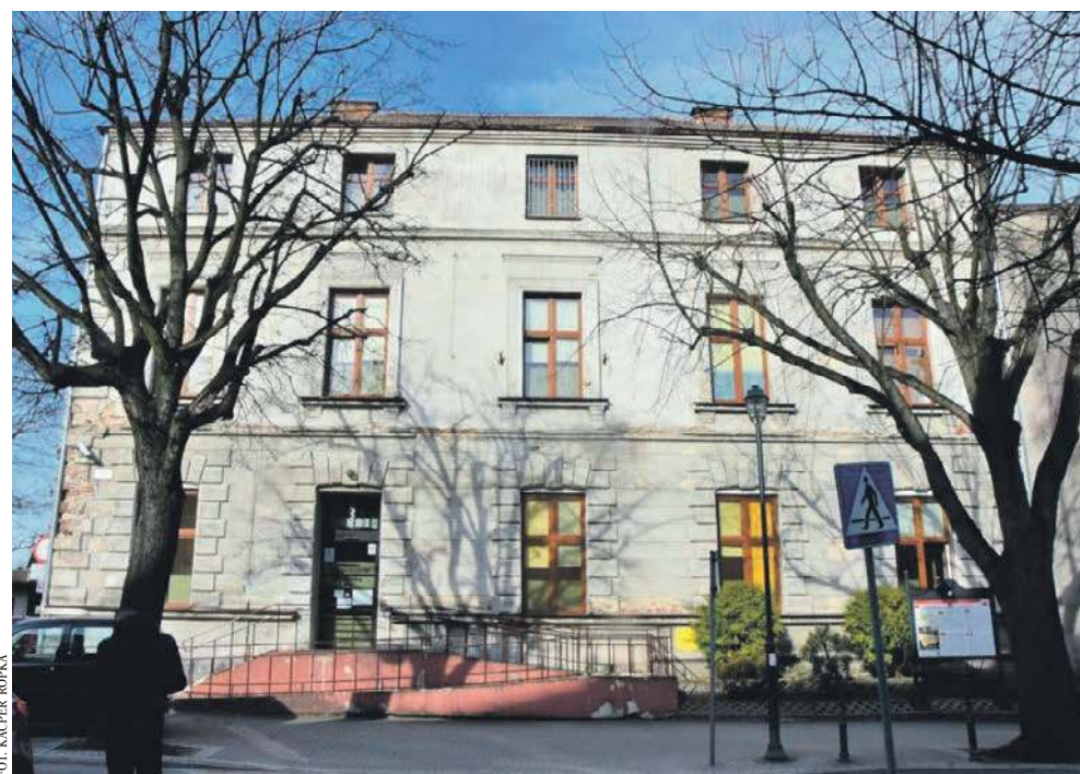
Zabytkowa kamienica przy ul. Krakowskiej przejdzie remont
