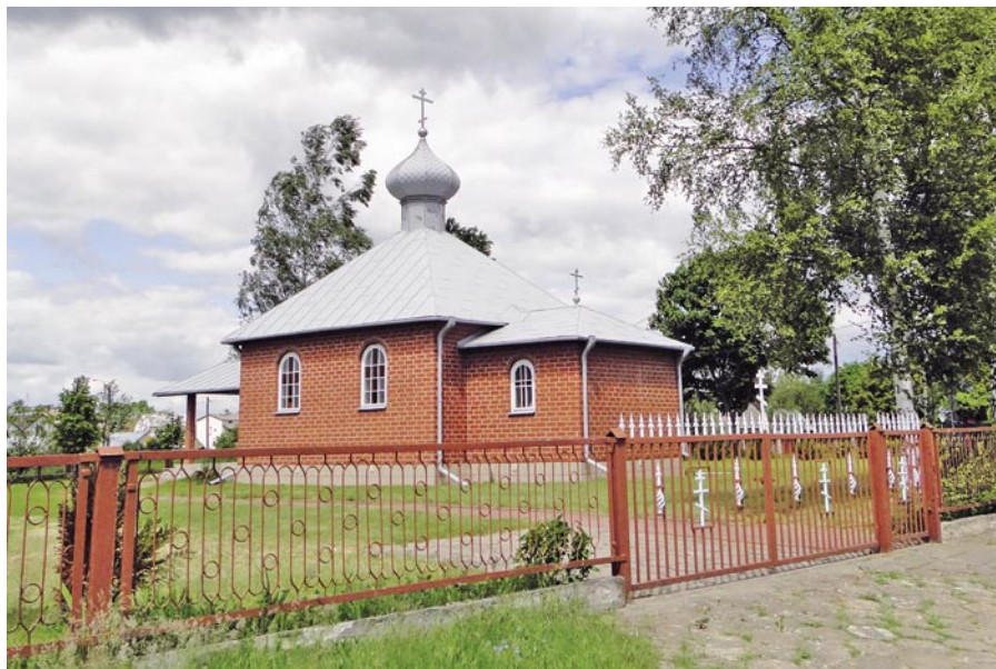
Kleszczelowska cerkiew św. Jurija (Heorhija Pobidonoscia) spłonęła w 1924 r. Na zdjęciu nowy budynek wzniesiony na jej miejscu w latach 90. XX w.
