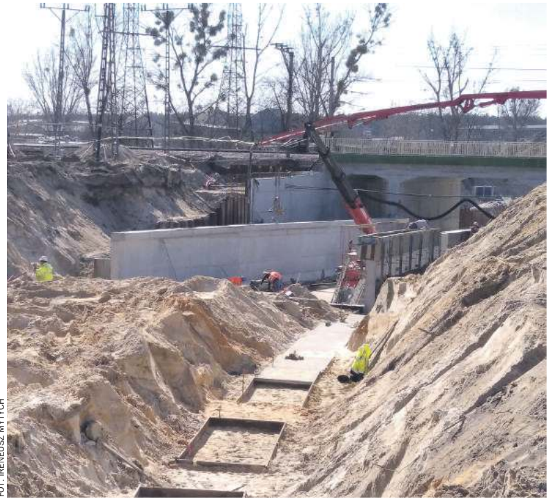
Zachodnia obwodnica Stalowej Woli: 65 proc. robót zostało już wykonanych
