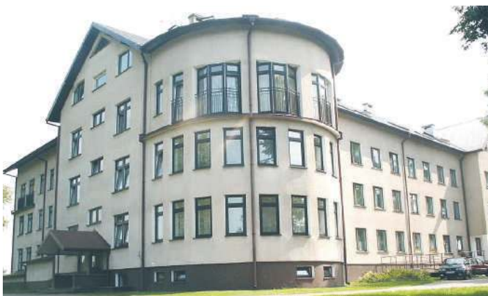
Dom Pomocy Społecznej w Krasnymstawie po termomodernizacji
