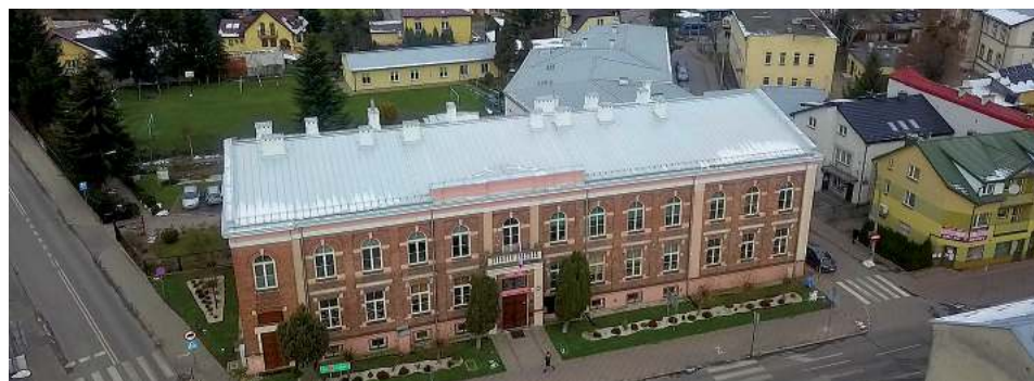
Nowe pokrycie dachowe Specjalnego Ośrodka Szkolno-Wychowawczego w Krasnymstawie
