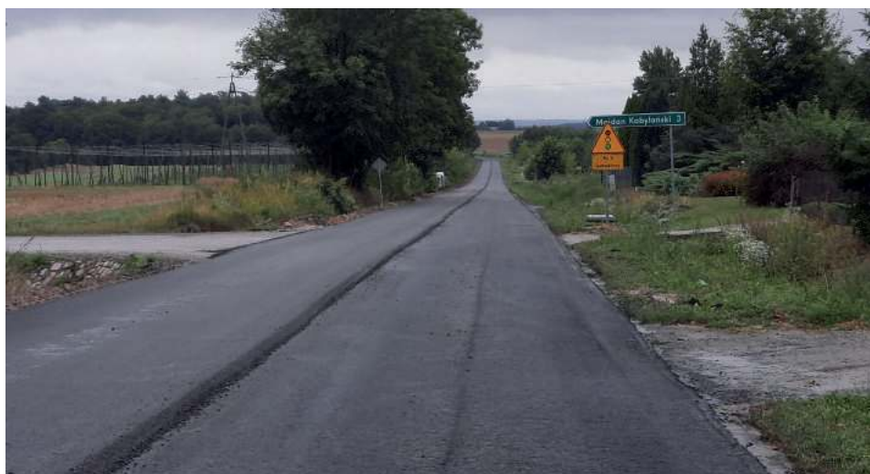
Rozbudowa drogi powiatowej Chorupnik - Rudnik - Mościska
