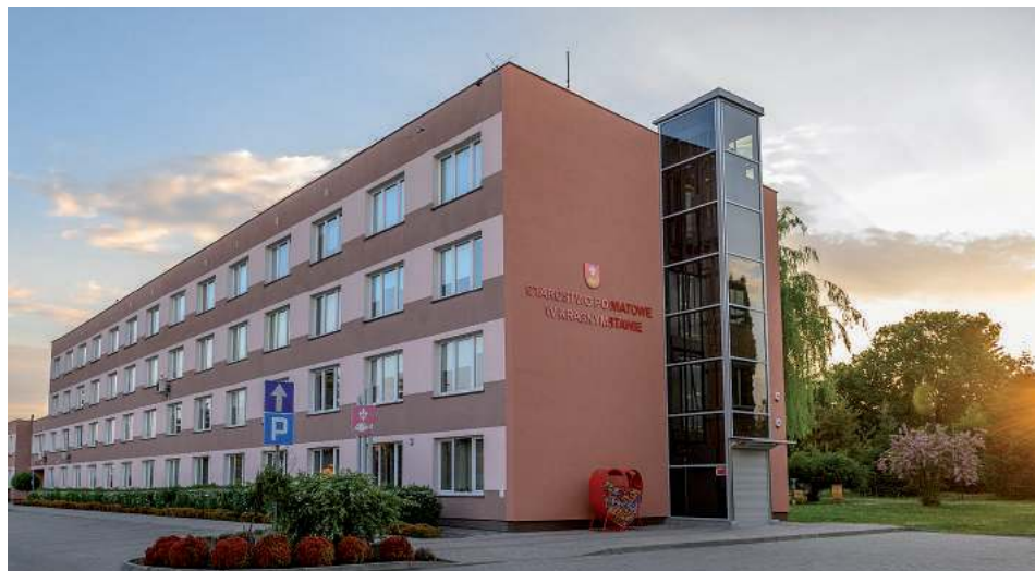
Winda w budynku Starostwa Powiatowego w Krasnymstawie
