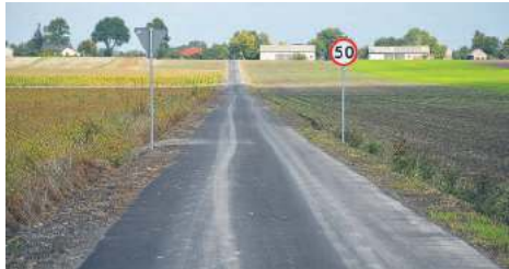
Przebudowa drogi dojazdowej w Żmudzi
