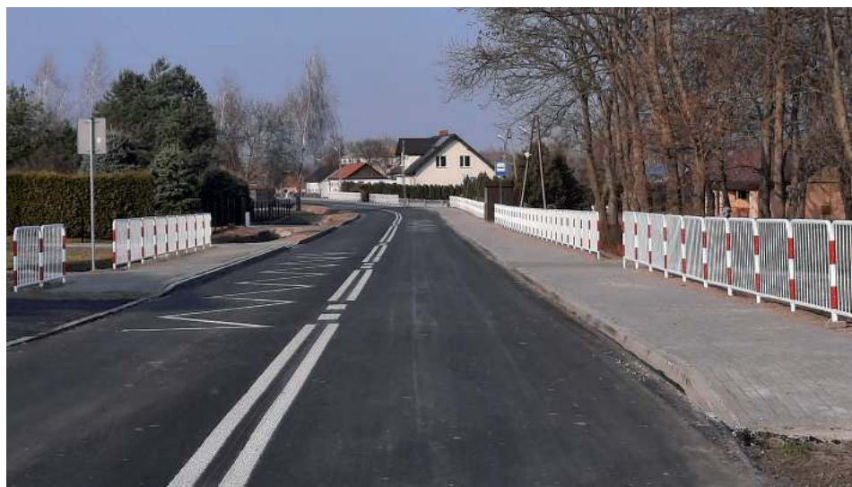
Rozbudowa drogi powiatowej w m. Wierchowiny, gm. Siennica Różana
