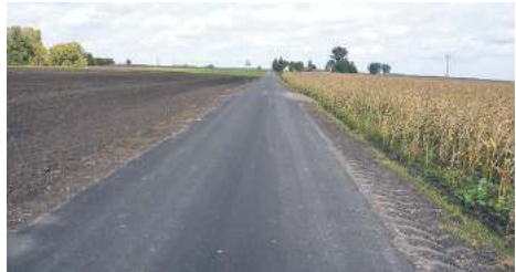
Przebudowa drogi w Klesztowie
