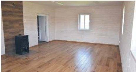
Remont sali w Izbie Regionalnej w Stanisławowie
