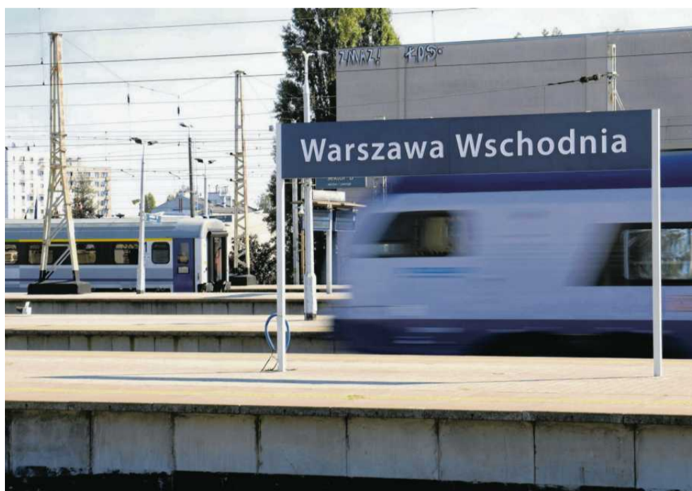
• Dworzec PKP Warszawa Wschodnia przed remontem FOT. ROBERT KOWALEWSKI / AGENCJA WYBORCZA.PL
