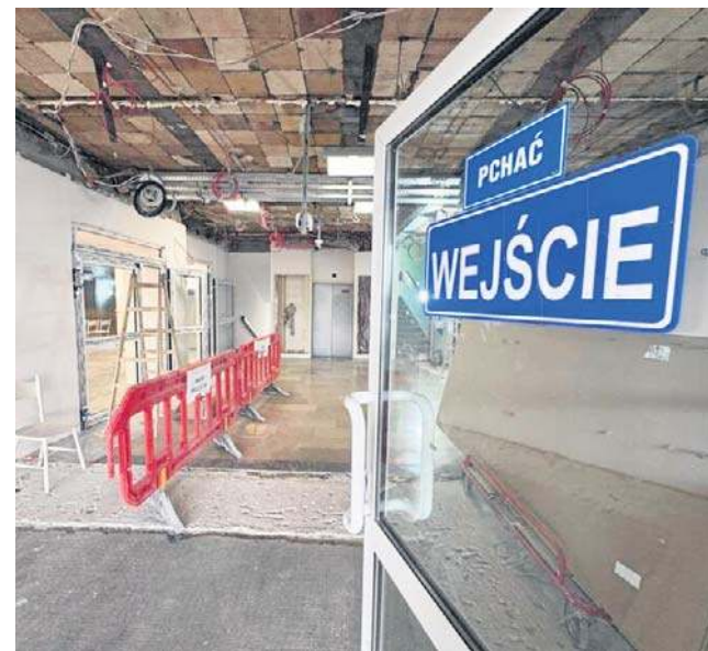
Powoli dobiega końca remont wejścia oraz holu głównego w kaliskim szpitalu.
