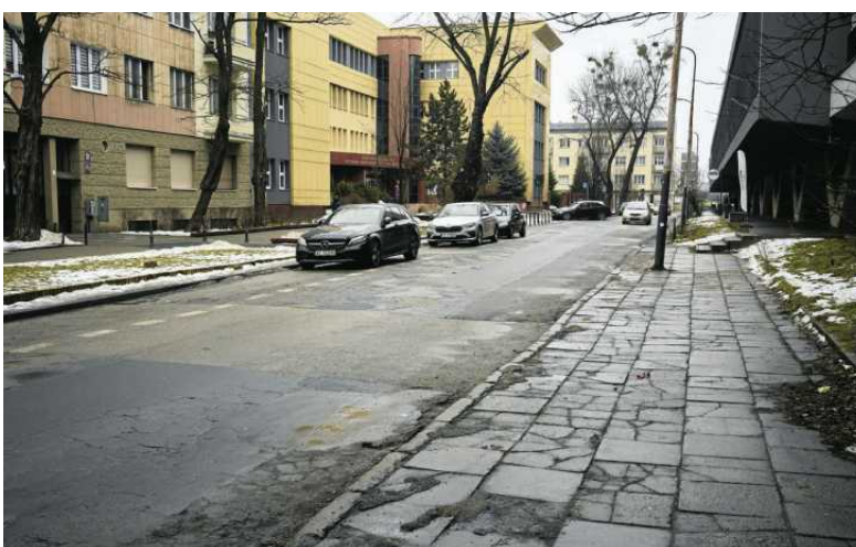
• Na czas prac przejazd ulicą Polskiej Organizacji Wojskowej na remontowanym odcinku będzie zamknięty FOT. MARCIN STĘPIEŃ / AGENCJA WYBORCZA.PL
