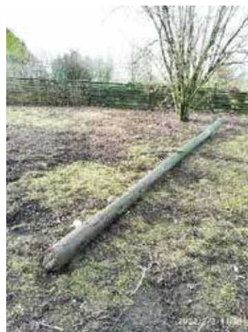
Przewrócony w wyniku silnych wiatrów w sobotę słup energetyczny. Awaria czeka na naprawę do dziś
