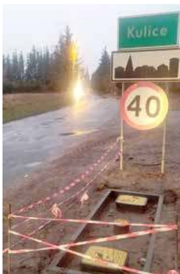
Jeden z przykładów wykonania prac gazyfikacyjnych, to tuż przy samym znaku wjazdowym do Kulic od strony Jarchlina
