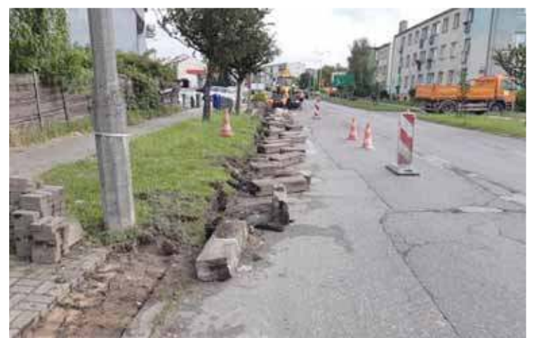
Wymiana krawężników na ul. Grzebskiego
