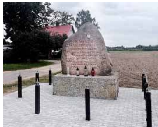
Obelisk z 1992 r. w trakcie renowacji
