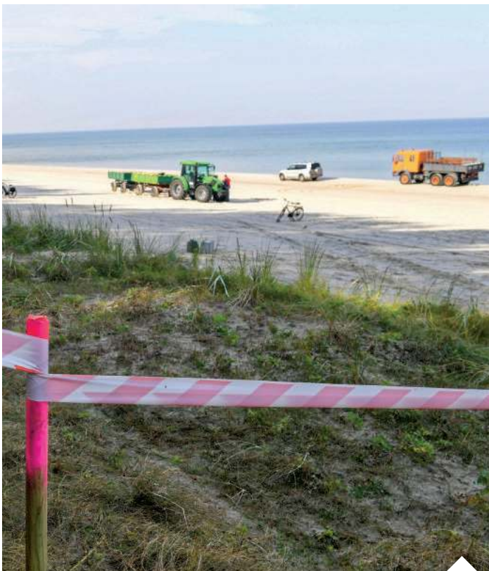
Ruszają prace przy przekopie przez Mierzę Wiślaną | fot. Adam Warżawa/PAP
