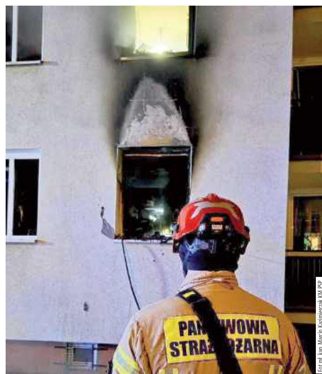
Wypalone okno w kuchni mieszkania, które spłonęło doszczętnie. Na pierwszym piętrze widać pękniętą szybę pod wpływem gorąca
