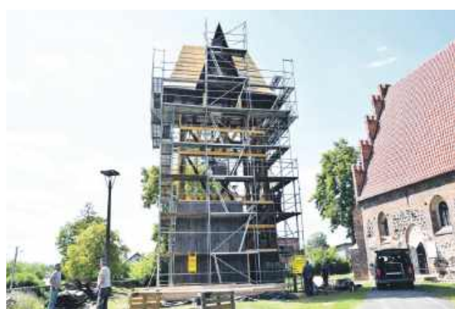
Remont dzwonnicy przy Kościele Parafialnym w Strzeszowie
