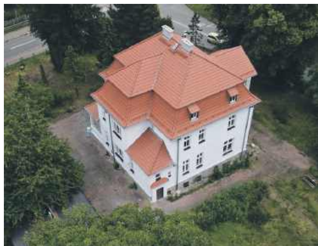
Te ściany zostały odnowione
