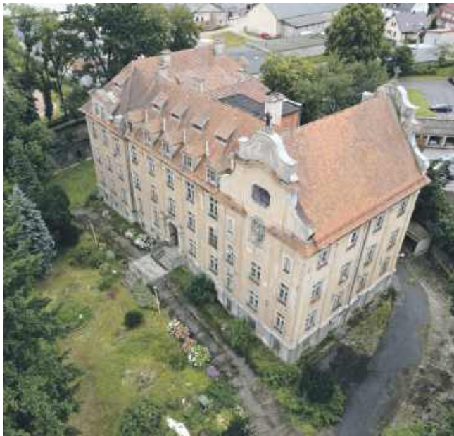
Budynek stoi i niszczeje
