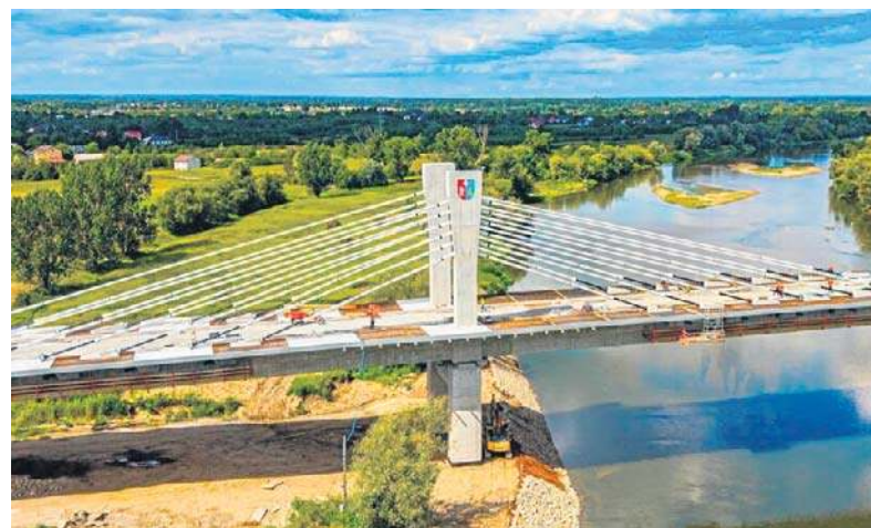
Budowa powinna zakończyć się w listopadzie
