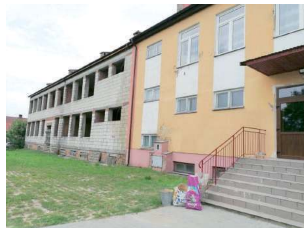
Mieszkania powstaną w Żabnie, gdzie od lat stoi budynek w stanie surowym
