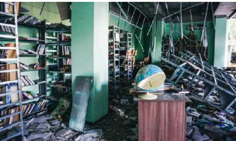
Zniszczona biblioteka w Pokrowsku.
