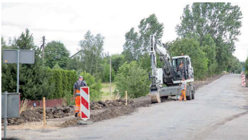
Trwa przebudowa ul. Kolejowej w Niemcach. Drogowcy wzmacniają konstrukcję jezdni na odcinku o długości 950 metrów oraz budują 650 m chodników, wraz z dwoma przejściami dla pieszych
