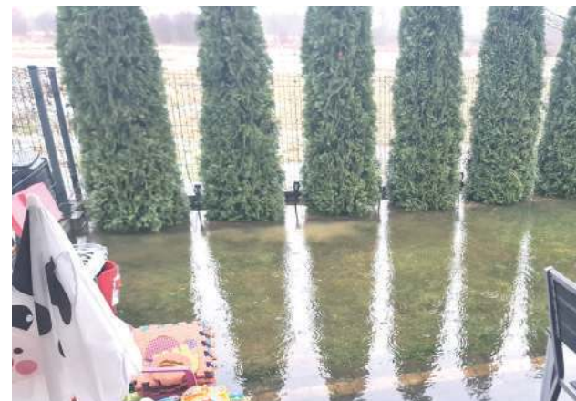
Brak odwodnienia i ukształtowanie terenu sprawia, że po deszczu podwórka mieszkańców Kolonii Sól, zamieszkujących szeregówki, są kompletnie zalane
