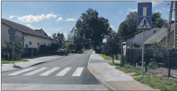
...i po przebudowie
