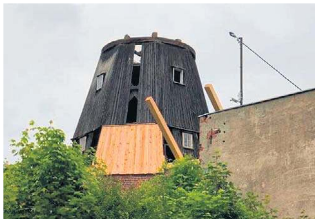
W Tczewie przeprowadzono remont zabytkowego XIX-wiecznego wiatraka typu holenderskiego
