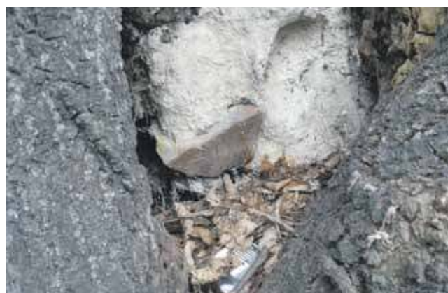
– Drzewa naprawdę są w złym stanie, obumierają. W środku są dziurawe, zalane betonem – mówią członkowie PTTK
