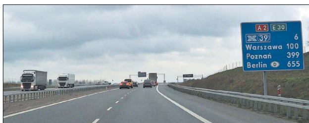
Budowa autostrady w kierunku wschodnim od Białej Podlaskiej znacznie się opóźnia, a już wiadomo, że autostrada nie dotrze do samej granicy
