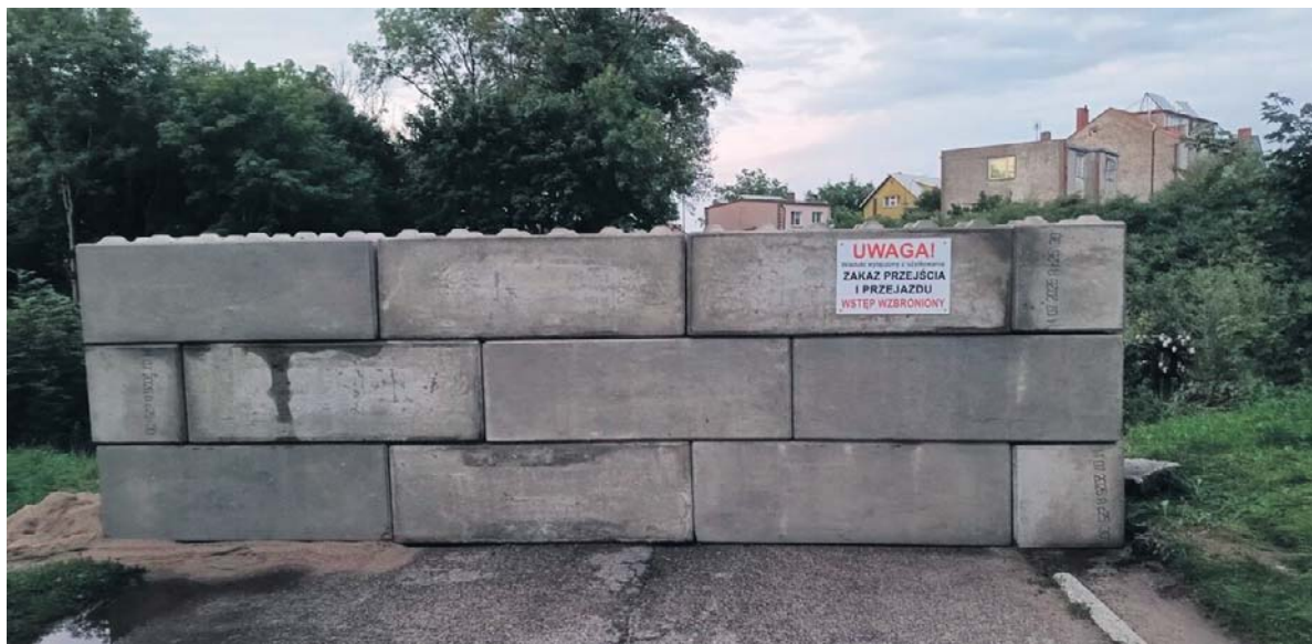
Na wiadukcie w Połczynie-Zdroju został wybudowany mur
