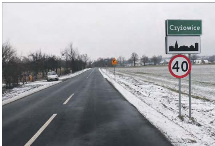
Zmodernizowana przy rządowym wsparciu droga z Prudnika do Czyżowic
