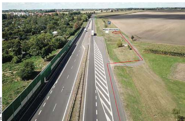
Inwestycja obejmuje dwa odcinki drogi ekspresowej S7 na Mazowszu
