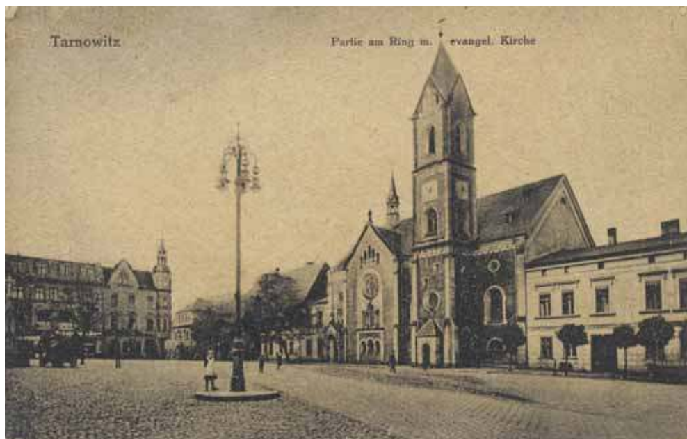
Kościół ewangelicki, po prawej stronie widoczny dom zarządu kopalni Fryderyk. Dziś w tym miejscu stoi „nowoczesny” budynek przypominający okręt
