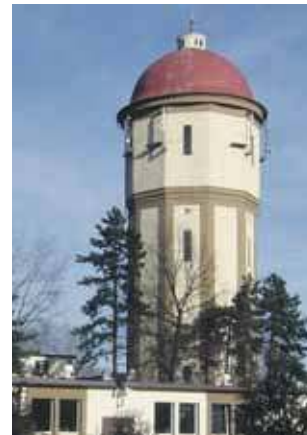
Wieża wodna wzniesiona w 1926 r. na Wzgórzu Redena obok szybu Kaehler
