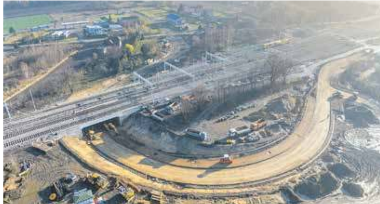
Rejon tunelu pod torami kolejowymi to wciąż wielki plac budowy
