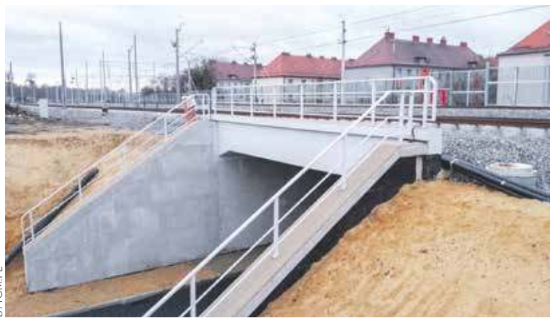
Odnowiony wiadukt nad ul. Dojazd
