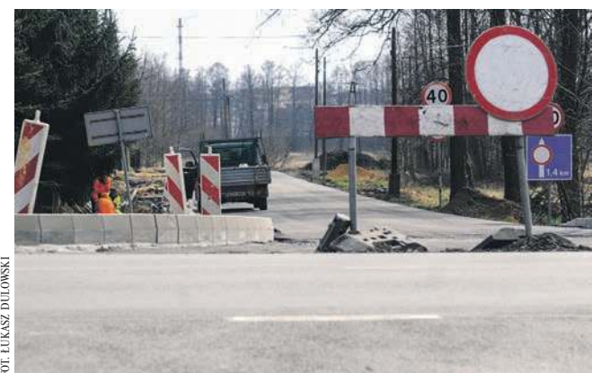
Na razie z ul. Mickiewicza w Alwerni nie można wjechać na modernizowaną ul. Krasickiego
