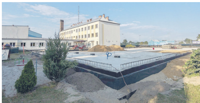
Budowa hali w Trzebieszowie Drugim
