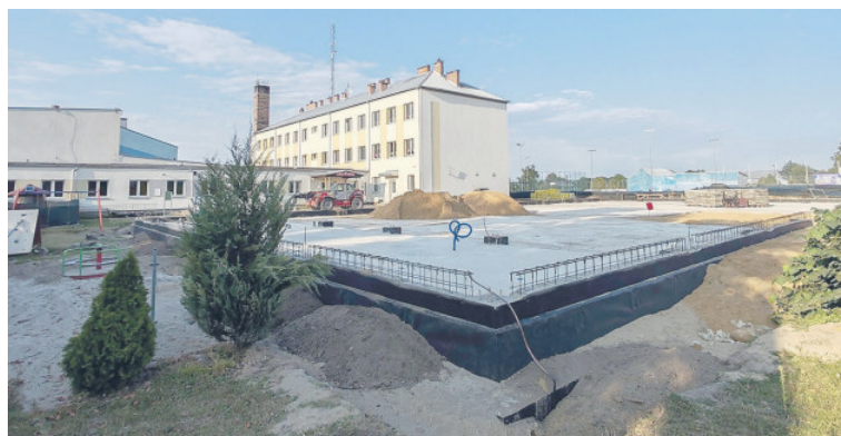
Budowa hali w Trzebieszowie Drugim
