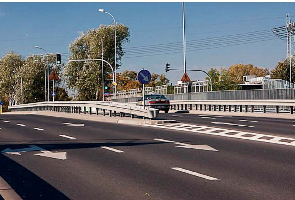
ką i Dygata | fot. Zarząd Miejskich Inwestycji Drogowych/d
