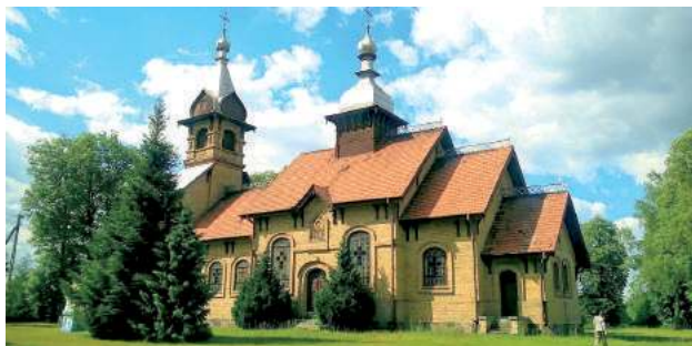
Przeprowadzona zostanie rewitalizacja dachu zabytkowej cerkwi pw. św. Mikołaja w Zabłociu. Koszt - 400 tys. zł
